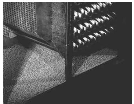
Şekil 9. Gaz yakan bir kalorifer kazanı arkasında yoğunlaşan su buharı. Yoğunluk ekonomizerlerde ve hava ısıticalarında duman tarafi direnci yaklaşık 25 mmSS'dir.
