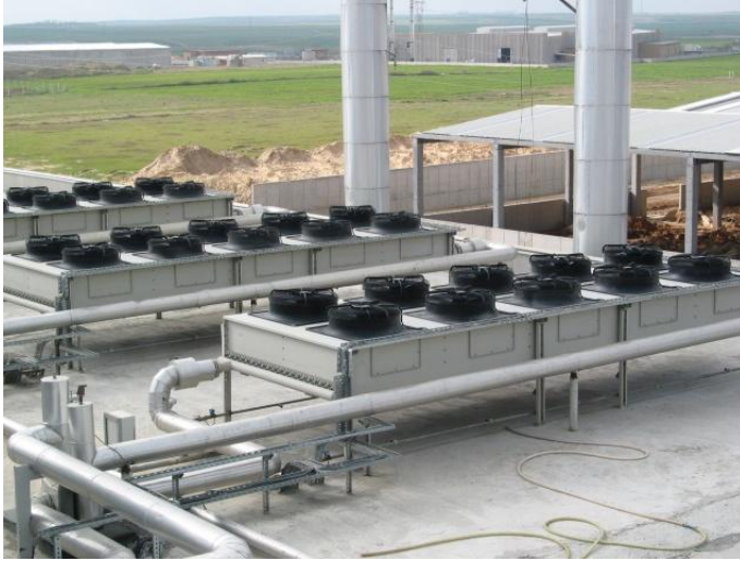
Şekil 17. Kuru Soğutucu ünite uygulaması [11]
