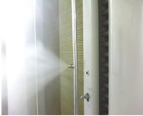
Şekil 23. Sisleme Sistemli Islak-Kuru Soğutucu [22]
