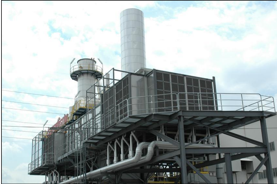
Resim.2- Türbin Giriş Havası Soğutma Ünitesi Uygulama Örneği
