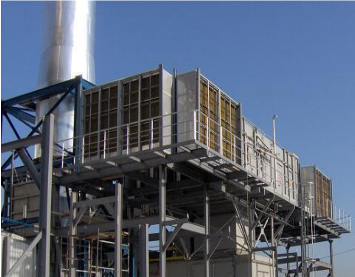
Resim.3- Türbin Giriş Havası Soğutma Ünitesi Uygulama Örneği
