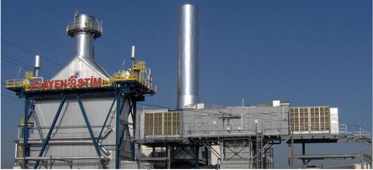
Resim.1- Türbin Giriş Havası Soğutma Ünitesi Uygulama Örneği
