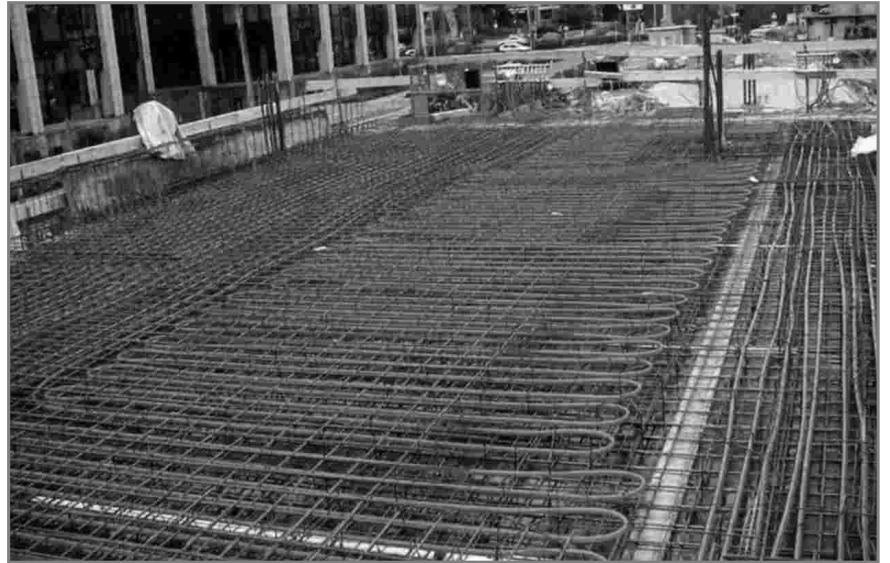
Resim 11. Tavandan ısıtma ve soğutma sisteminde borular inşaat yapımı sırasında döşenmektedir.
