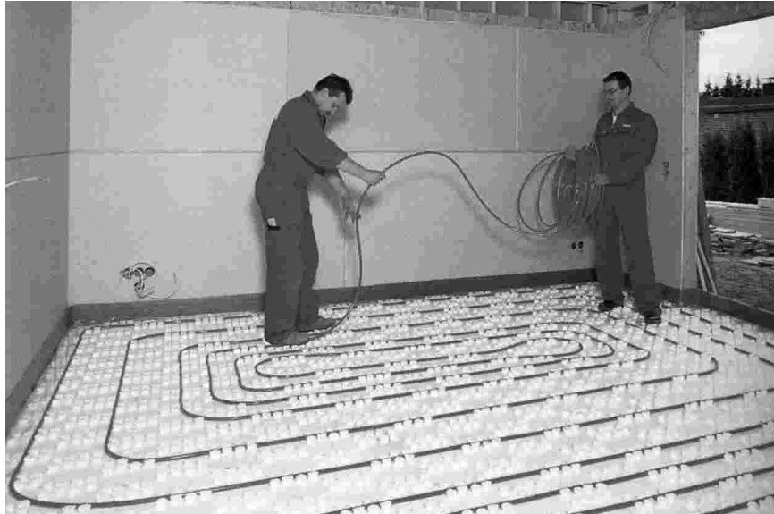
Resim 6. Yerden ısıtmanın uygulama şekli.
